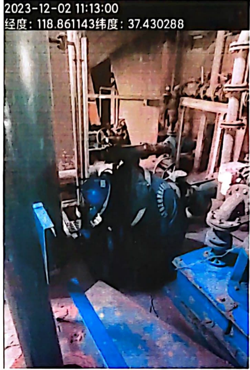
DW002脱硫废水排放口
